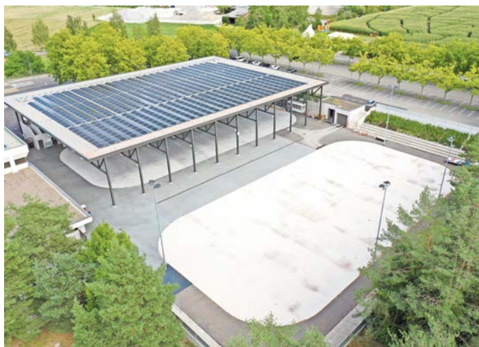
Outdoor-Eventarena – überdacht oder unter freiem Himmel
